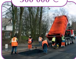
Travaux de voirie
