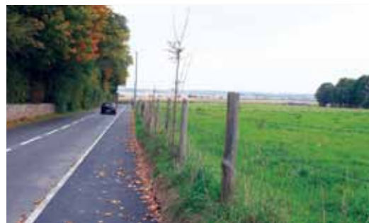
Rue Pasteur - Création d'un trottoir menant jusqu'au Poney club (Conseil départemental).
