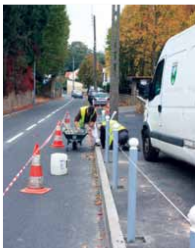
Rue Pasteur - Installation de poteaux de sécurisation des piétons.
