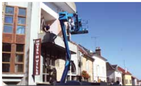
Mairie - Rénovation des châssis et remplacement des fenêtres.
