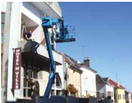
Patrimoine communal : changements des fenêtres et châssis en Mairie.
